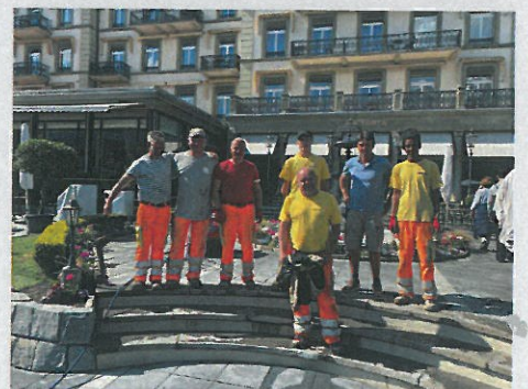
Impressionen der Bauarbeiten sowie ein Bild der strahlenden Mannschaft am Gründonnerstag
